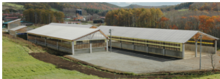
くずまき高原牧場堆肥生産プラント
